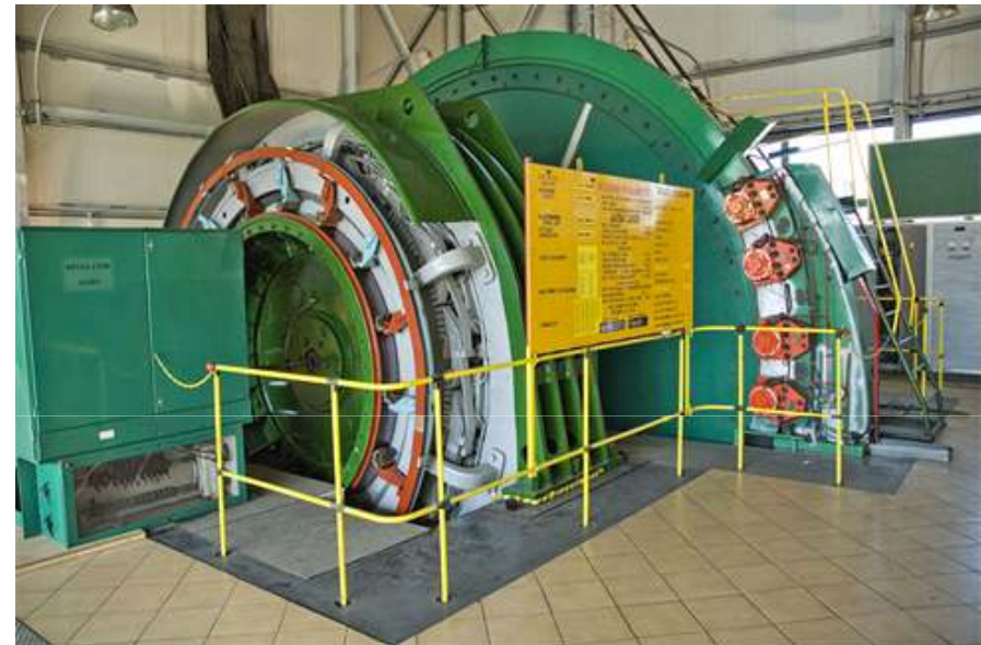
Maszyna wyciągowa 2,4 MW (zasilana prostownikami tyrystorowymi o mocy 4 MVA)
