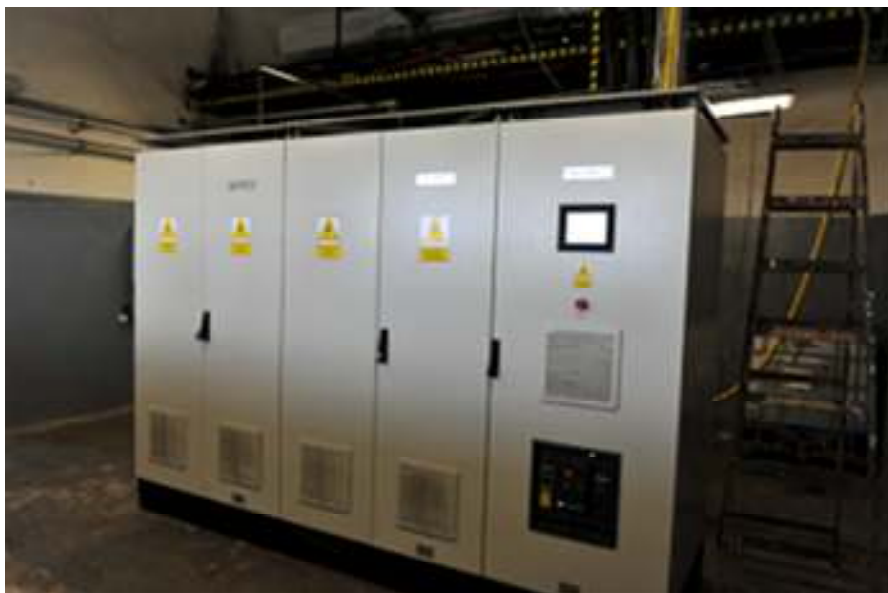
System RKA (2 falowniki NPC)
