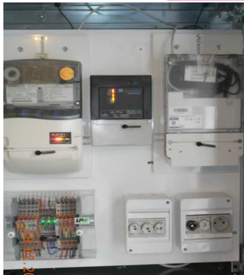
Zainstalowane urządzenia AMI w układzie bilansującym na stacji SN/nN
