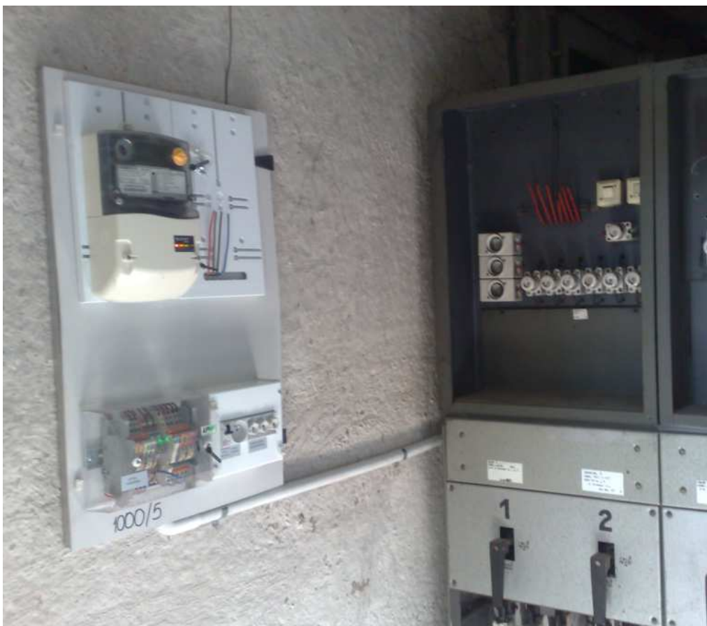
Dostosowanie układu bilansującego pod wymogi zabudowy urządzeń AMI
